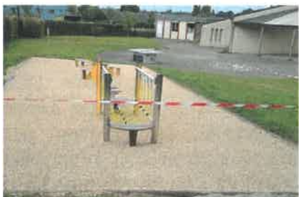
On n'attend plus que le passage de la commission sécurité pour la mise en service.
